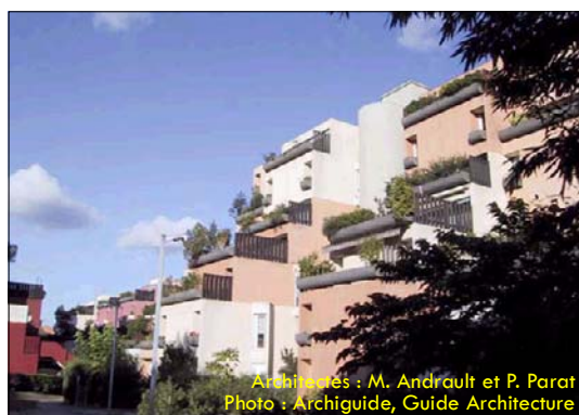
Habitat à gradins à Talence (33).
